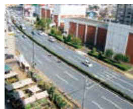
ヒートアイランド現象を抑制する遮熱舗装道路
